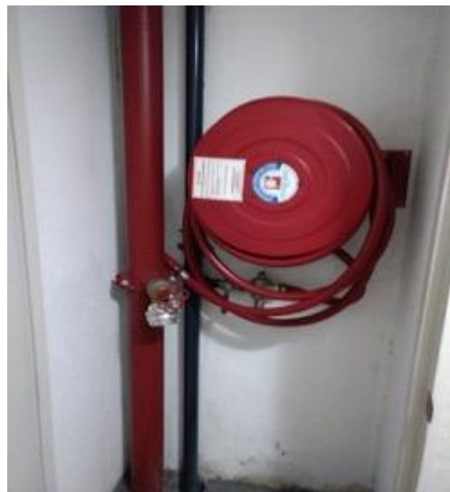
Red Húmeda del Edificio
