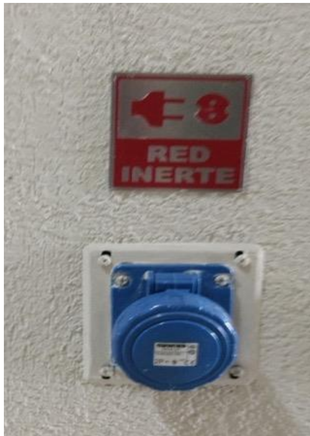
Salida Red Inerte por Piso
